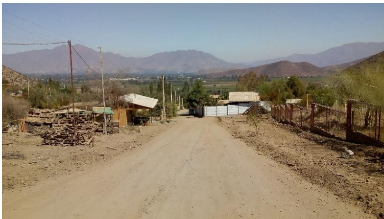
Fotografía 2: Sector Alto de Las Cabras, este es uno de los sectores más nuevos dentro de la localidad donde aún se aprecian viviendas en construcción, además, se puede ver que en este sector las calles no son asfaltadas, tampoco cuentan con luz, ni agua para las viviendas.
