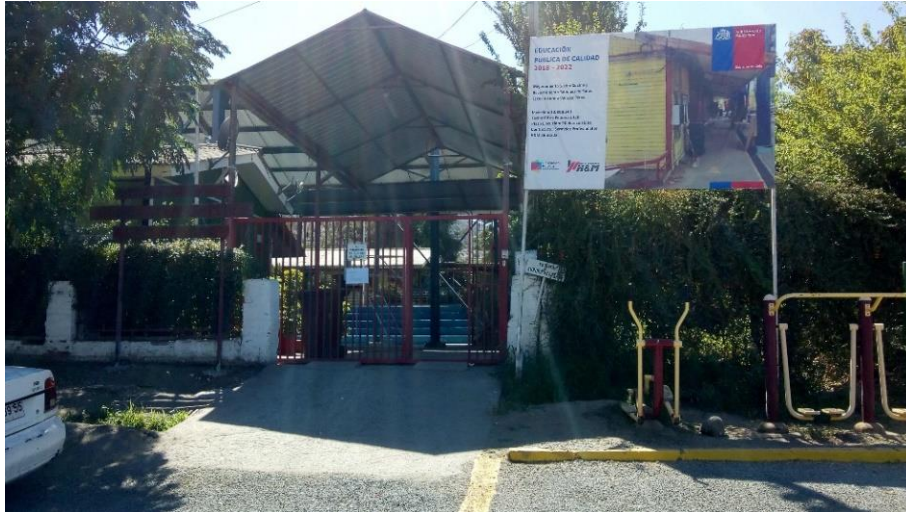
Fotografía 3: Escuela Básica Aurora Velazco Pérez, se emplaza en el sector bajo de la localidad y a la entrada del pueblo.
