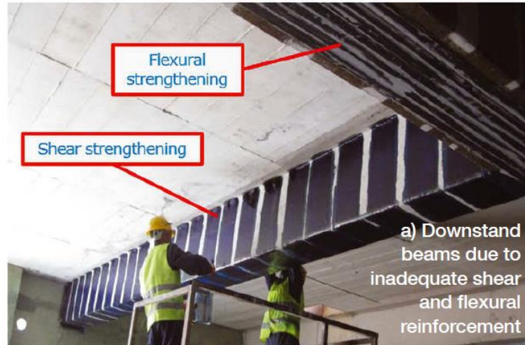
figura 5.14 – Implementación de FRP para un refuerzo inadecuado para corte y flexión [34]
