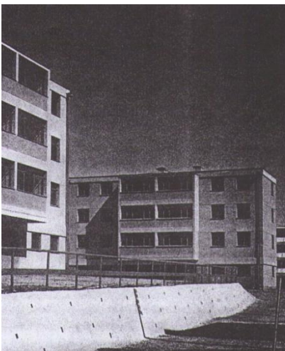
Foto 9, 10._ De las obras de la Población publicada en el Diario La Unión.
