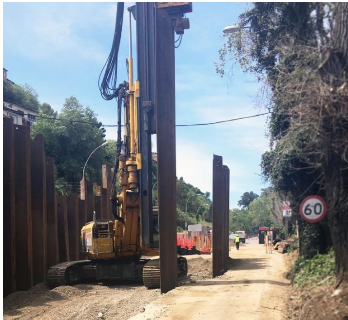
Figura 6.7.1 - Instalación de tablestacas en Constitución. Fuente: Mecanotubo Chile [3].
