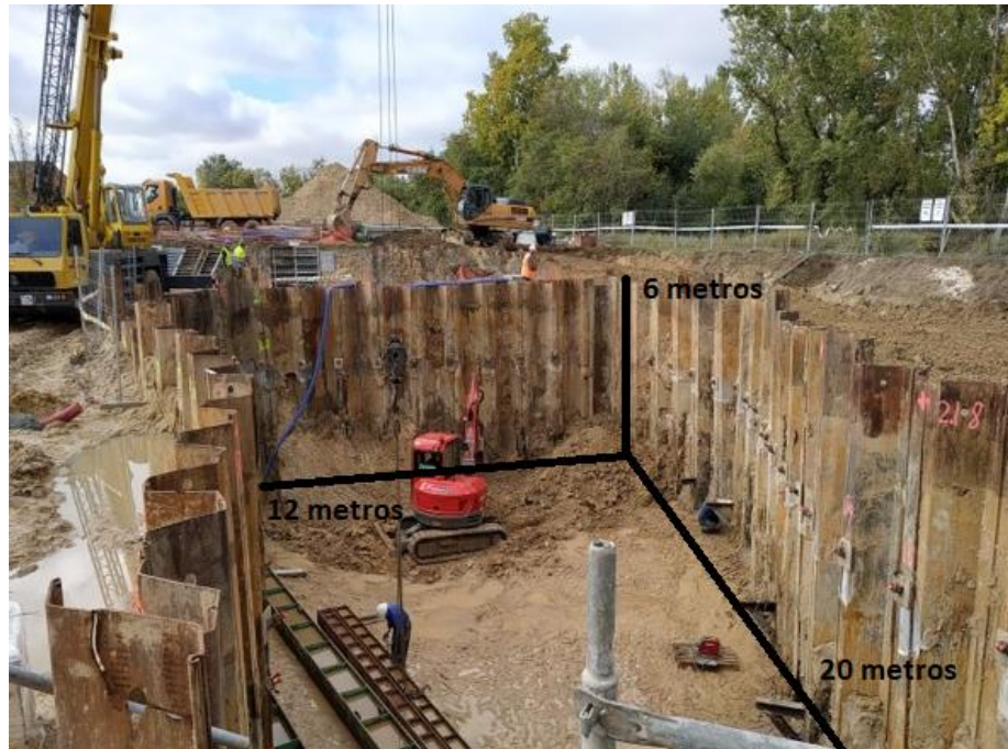
Figura 8.2.2 - Excavación para evaluación económica de sostenimiento de suelos con muro tablestacado. Fuente: Mecanotubo Chile, 2021.
