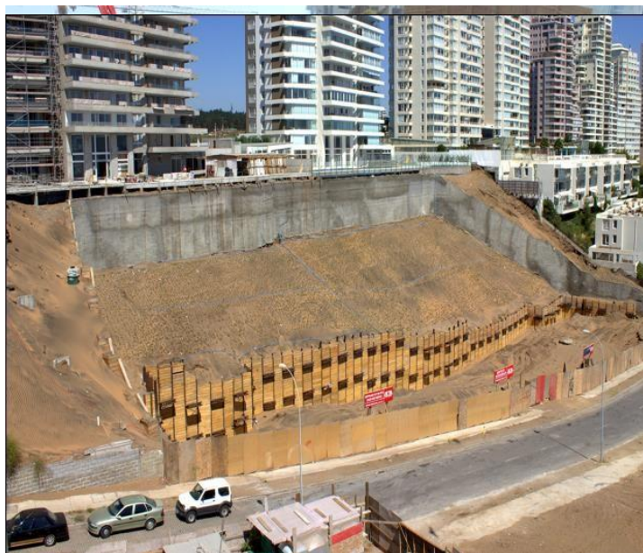
Figura 6.7.2.7.(b) - Muro berlinés, edificio BORDEMAR en Reñaca, región de Valparaíso, Chile. “Inmobiliaria Bezanilla”. Fuente: “Ferrara”.
