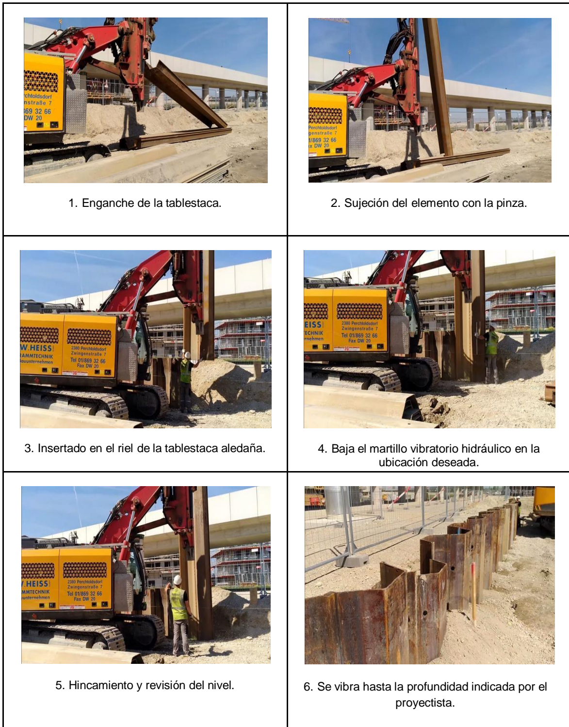
Figura 6.7.1.3 - Proceso instalación sistema sostenimiento tablestaca. Fuente: Mecanotubo [3].
