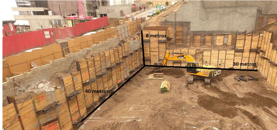
Figura 9.1 - Excavación para evaluación económica de sostenimiento de suelos con muro berlinés. Fuente: Flesan.
