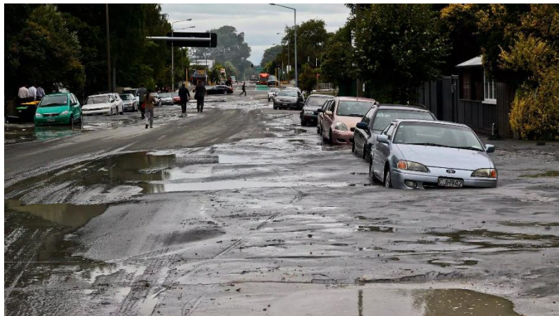
Figura 6.5.7 – Efecto de licuación de suelos. Fuente: Geotecnia online, 2017.
