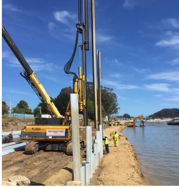
Figura 6.7.1.8.(a) - Tablestacas borde costero en Constitución región del Maule, Chile. Máquina RTG. "Arrigoni Ingeniería y Construcción S.A". Fuente: Mecanotubo [3].
