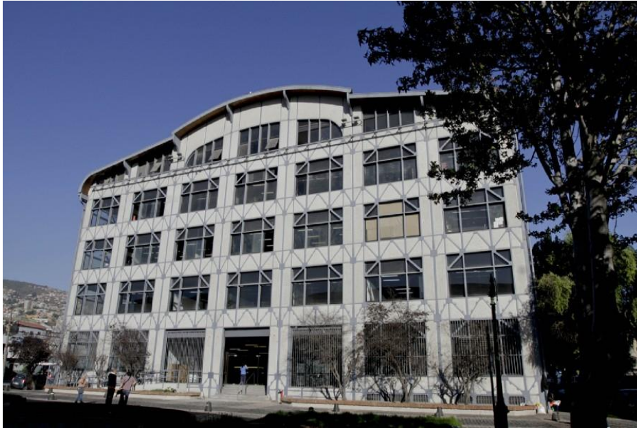
Figura 2.1.2 Edificio Hucke en la actualidad.
