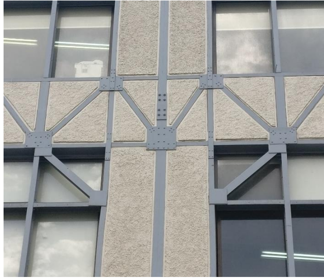
Figura 4.4.4 Perfiles estructurales fachada oriente.
