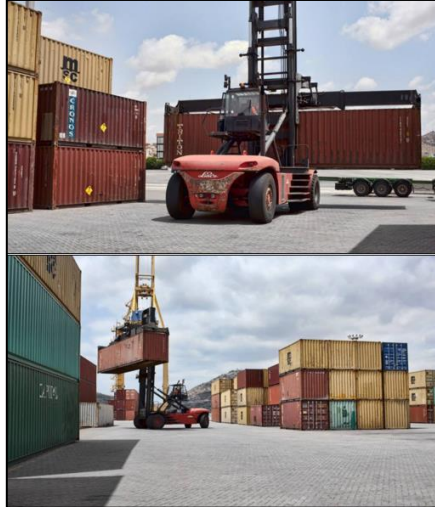
Figura 2.16: Adoquín utilizado en patios de carga y zonas portuarias.[15]
