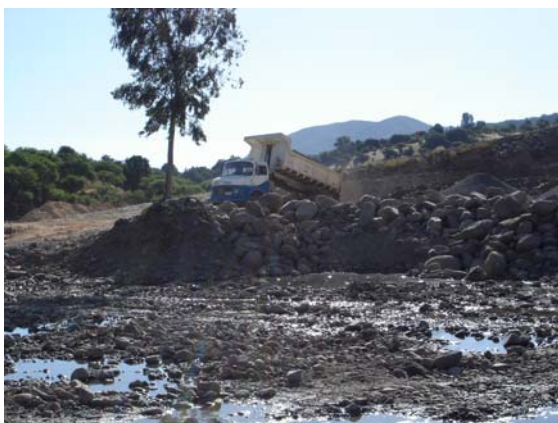
Figura N° 8: Presencia de maquinarias
