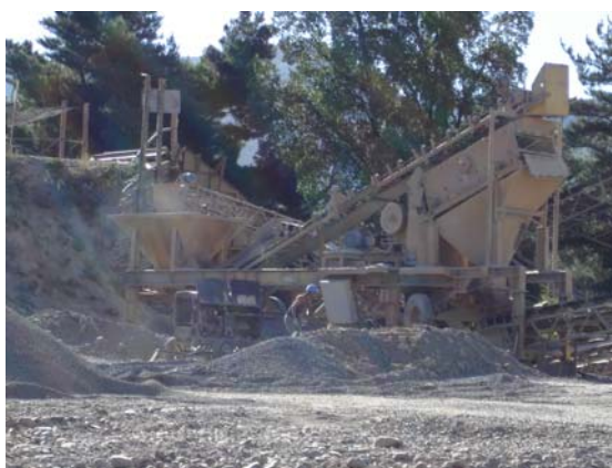
Figura N° 9: Presencia de maquinarias
