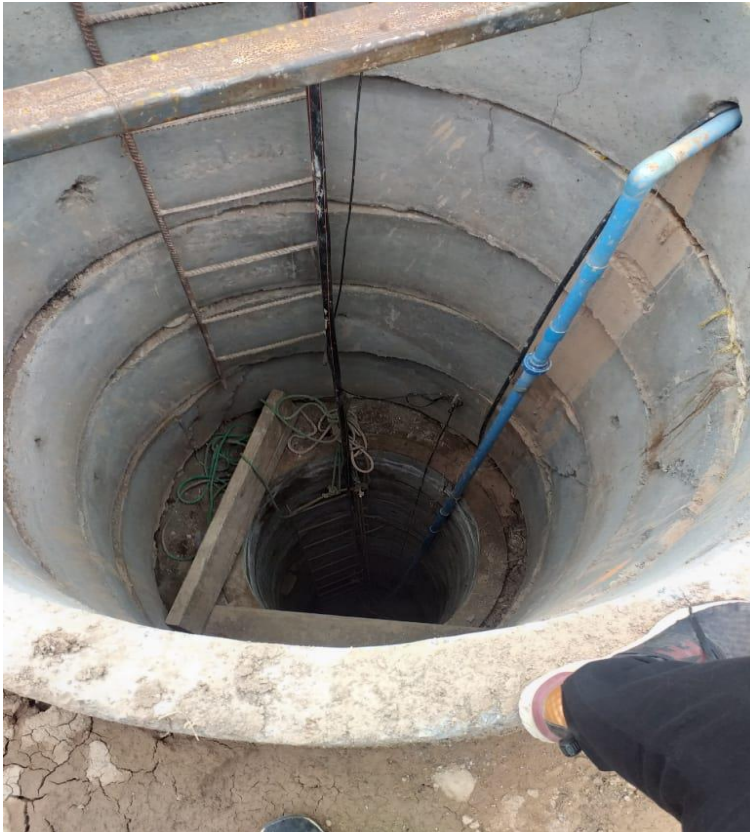
Ilustración 8: Pozo Quebrada de Castro
