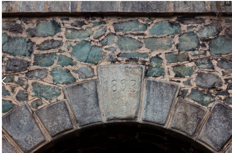
Fig. 6 Túnel Cavilolén recuperado: septiembre 2023, El diario de Illapel
