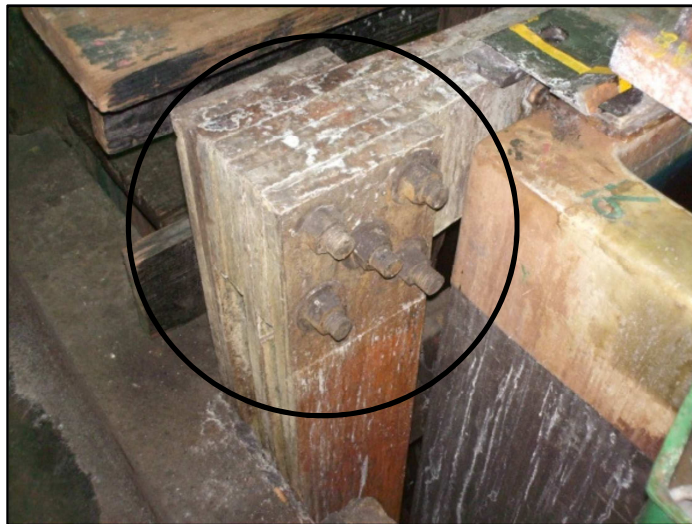
Figura 3.7 – Fotografía de unión barras conductoras. Fuente: (CODELCO, 2013)
