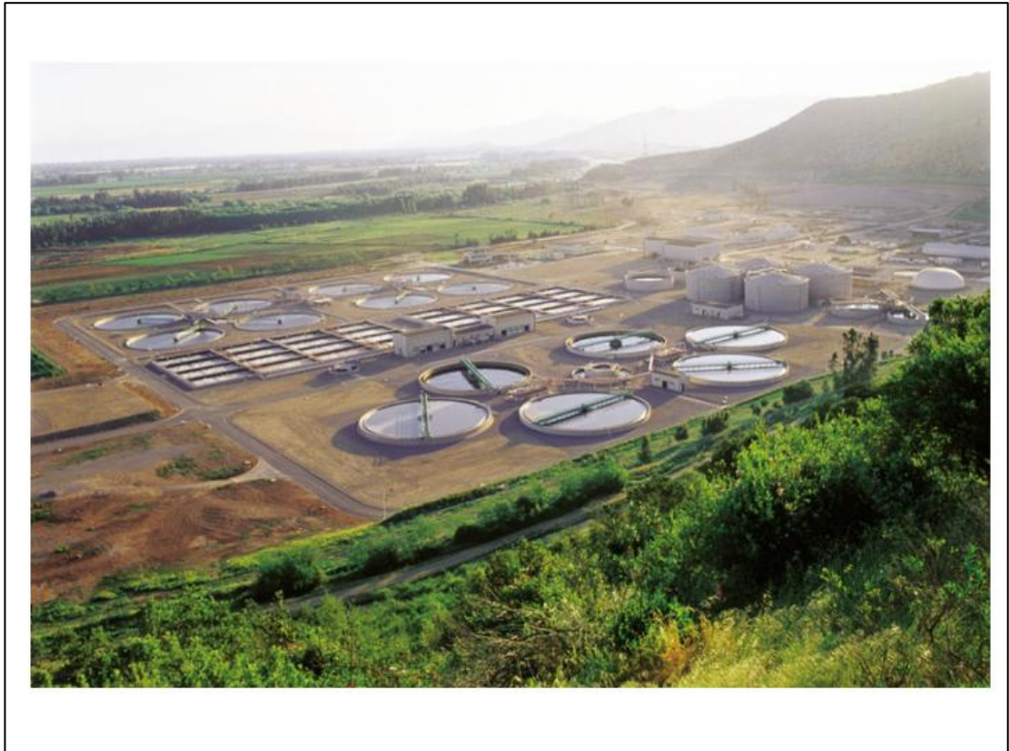
Figura 5.3 Foto panorámica general de planta El Trebal (Aguas Andinas, 2000)
