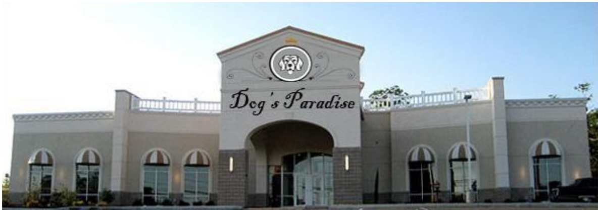
Figura 3.8: Fachada del hotel canino (Imagen Referencial).
