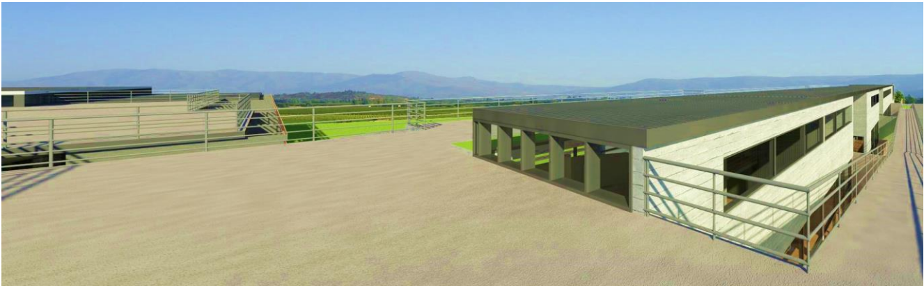
Vista Superior desde cubierta caminable.
